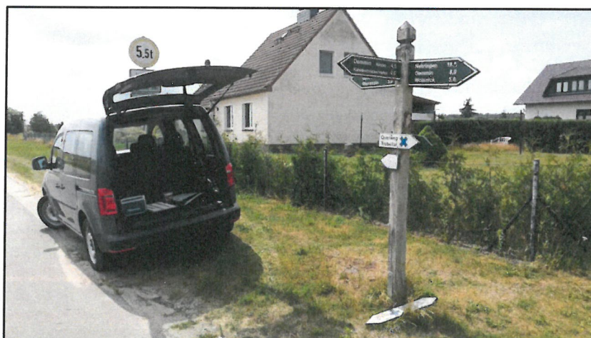
Abbildung 1: Zustand/Wartung der desolaten Radwegweisung am Radfernweg Hamburg – Rügen in Demmin
