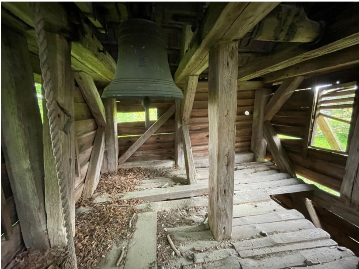
Glockenstube im Obergeschoss
